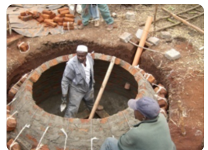
Bau von Biogasanlagen für Haushalte in Kenia
